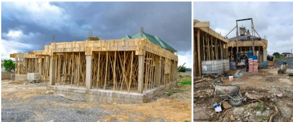
Ondersteuning 1e verdiepingvloer
