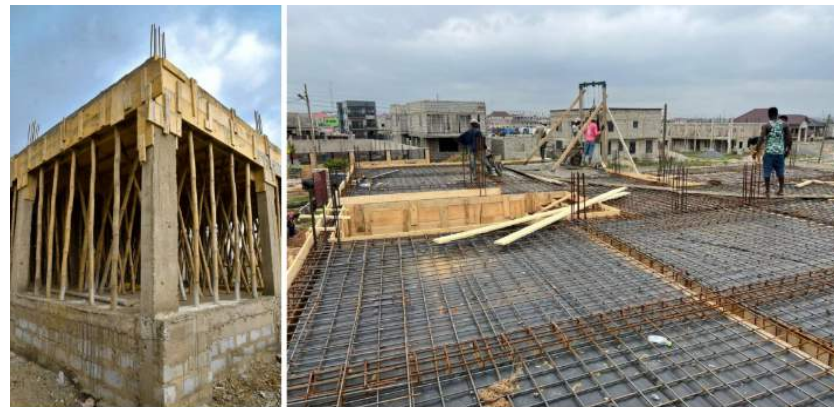
Storten 1e verdiepingvloer
